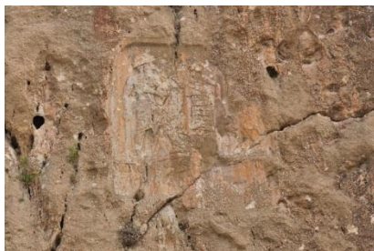
شکل ۱۰. شکستگی‌های ناشی از تنش‌های مکانیکی موجود بر سطح نقش برجسته آنوبانی‌نی.
