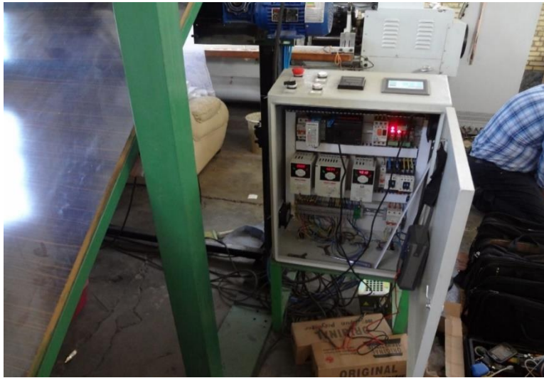
شکل ۱۱. تست تابلو کنترل.
