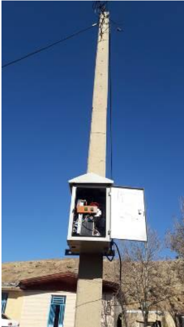
شکل ۱۰. نصب میدانی SSVR نیمه صنعتی ۵KVA در روستای پایتخت ۳ کاکاشرف خرم‌آباد.
