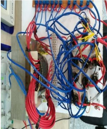
شکل ۱۵. مدار قدرت شامل کلیدها و اتوترانسفورماتور
