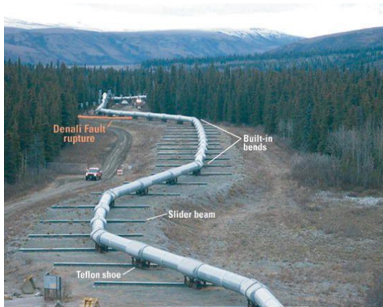
شکل ۴. خط لوله انتقال روغن ترنس-آلسکا در ناحیه متقاطع با گسل دنالی ۱ [۱۳]
