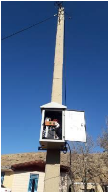
شکل ۱۰. نصب میدانی SSVR نیمه صنعتی \Delta KVA در روستای پایتخت ۳ کاکاشرف خرم آباد.
